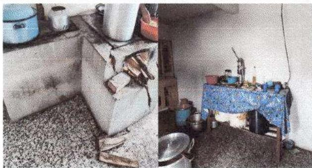
Foto 5: Plancha en mal estado, sin azulejo. Mesa de madera en mal condición para elaboración de alimentación escolar.
