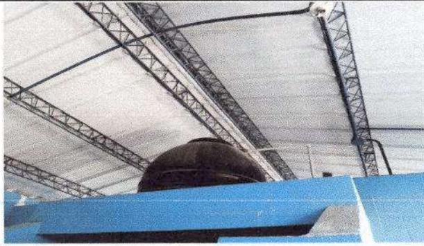
Foto1: Deposito de agua en mal estado de 1500 lt.
